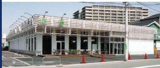
鉄骨平屋建の屋根（折板）と外壁（ALC）の全面にガイナを採用して頂きました。当初計画では11.2馬力のエアコン16台設置予定でしたが、6台も減らした10台で営業をはじめ、苦情は一切無いまま既に3回目の夏を過ぎました。エアコンの温度設定も26～28℃で十分涼しいと喜ばれています。金額面でも、当初計画では年間の電気使用を約340万円と予測していたのですが、エアコンを減らし、ガイナによる効率アップで、年間約210万円にまで抑えることができました。塗装工事で追加となった費用420万円も、その差額でほぼ償却できており、非常にコスト削減になりました。さらに、冬期も大きなガラス面に結露が発生することもなく、足元の冷えも感じなくなったということです。
